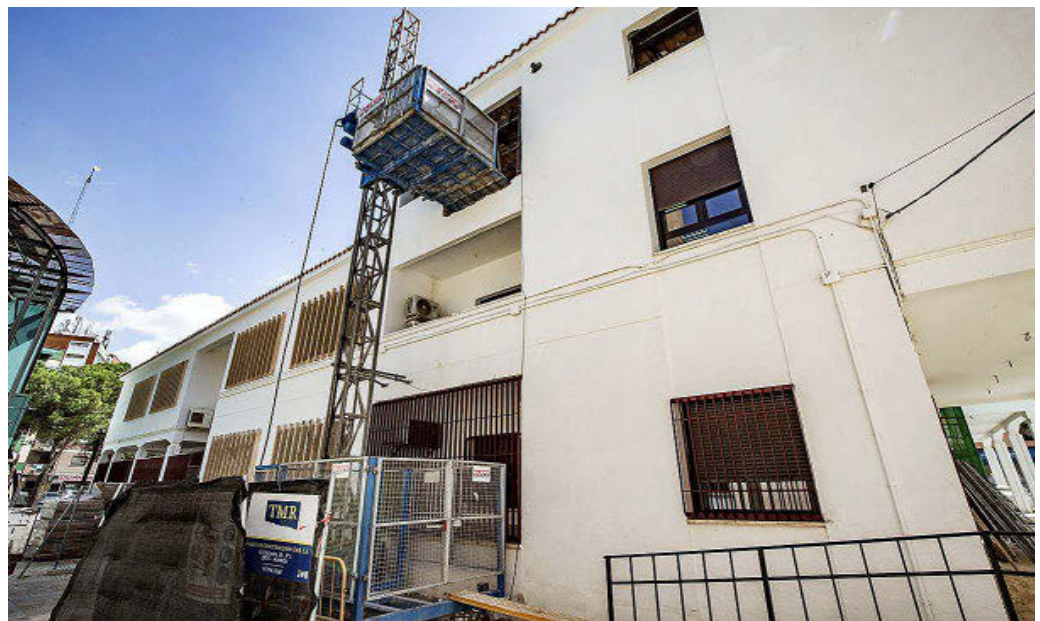
Las obras tienen un plazo de ejecución de 18 meses. / RUEDA VILLAVERDE
